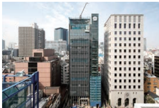
建設工事現況（平成25年3月28日現在）
