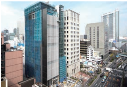
建設工事現況（平成25年3月28日現在）
