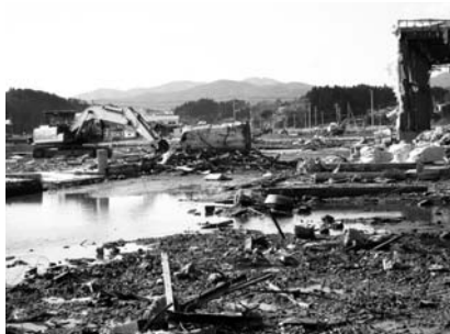
地盤沈下した地区は瓦礫撤去後嵩上げしなければ使えません
