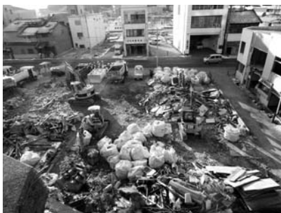
この写真で解体されずに残るのは2軒だけです
