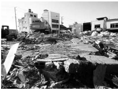
魚町の解体作業
