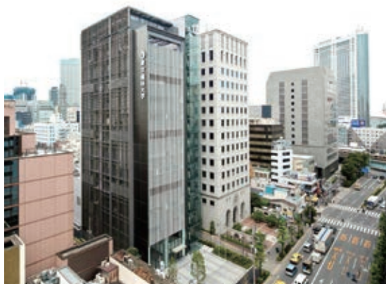
新館南面および水道橋駅方面
