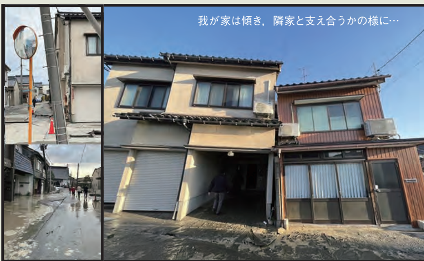
'24.1.2未明 めくれたアスファルトで車がスタックした
