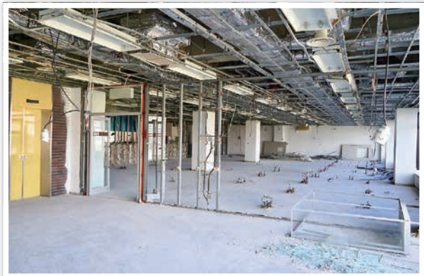
病院棟3階。補綴科診療室。(07.18.2021)
