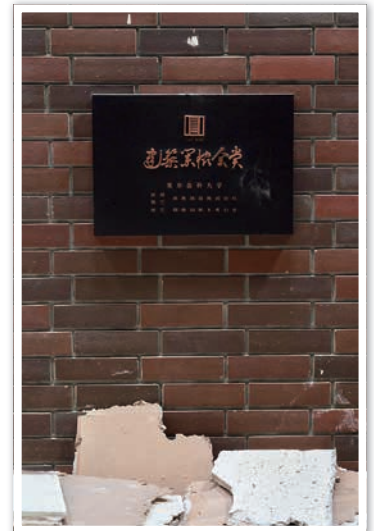
管理棟エントランスホールの壁に残る，建築協会賞受賞の銘板。(07.18.2021)
