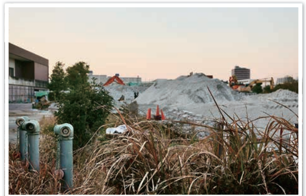
想い出の建物はすべて瓦礫となり，錆びた消火栓が，かつて教養棟から基礎棟へ向かう扉がそこにあったことを示している。(12.12.2021)
