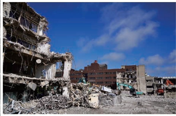
基礎棟跡から，取り壊し中の臨床棟を望む。(07.18.2021)
