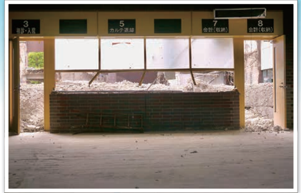
病院棟1階，千葉病院受付。正面の壁だけが残る。(10.10.2021)
