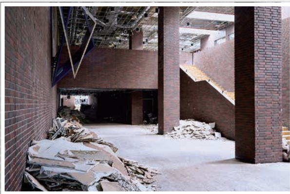
取り壊しの始まった管理棟エントランスホール。床のタイルが灰色にくすむ。(07.18.2021)
