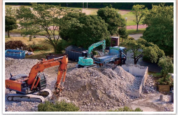
教養棟の取り壊し。(07.24.2018)
