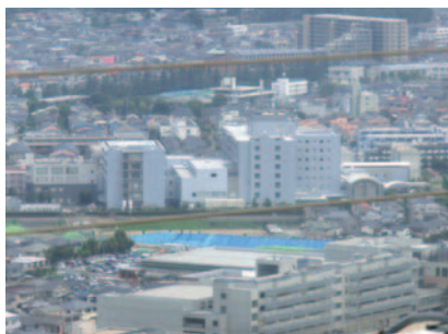
高層マンションから見た市川総合病院
