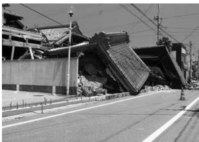
今回の地震により倒壊した町内の家屋
