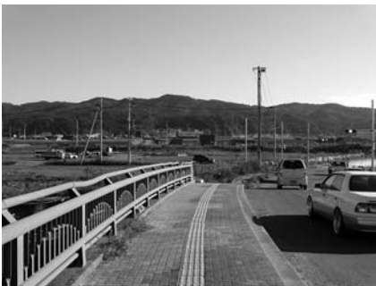
現在瓦礫は撤去され電信柱が立ち仮設道路が出来。 土地の高上げ工事が始まっています。 2013年10月18日撮影
