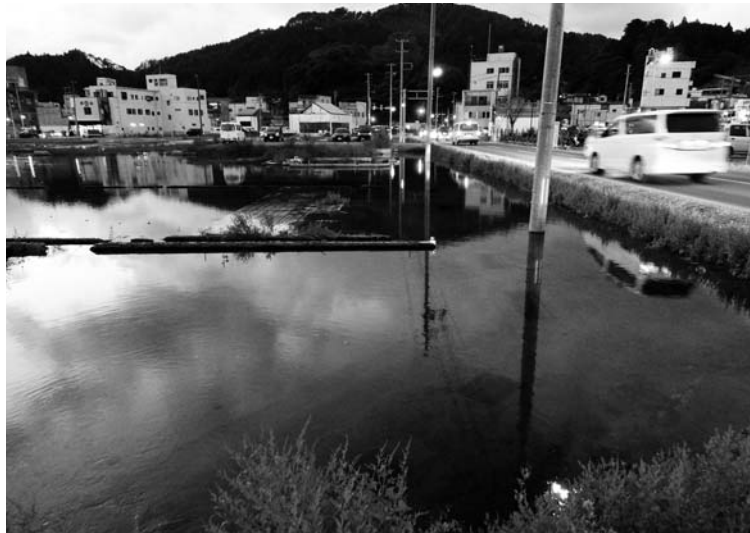
東日本大震災の復旧で一番の問題は地盤沈下です。 気仙沼で約74センチの地盤沈下です。 ここでは満潮時冠水するので道路だけ仮の高上げをしています。 住宅の基礎はまだそのまま残っています。 遠方の建物は高上げ工事のため全部撤去される予定です。 2013年10月10日夕方撮影
