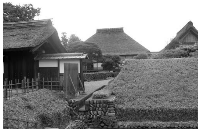
足利学校全景『茅葺屋根』
