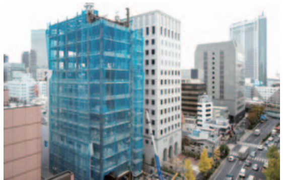
(図15) 新館建設工事現況(2012年11月24日現在)
