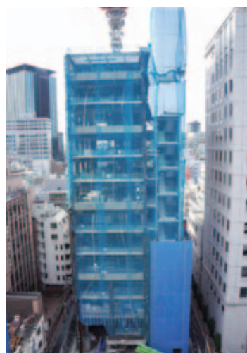
(図16) 新館建設工事現況(2012年11月24日現在)
