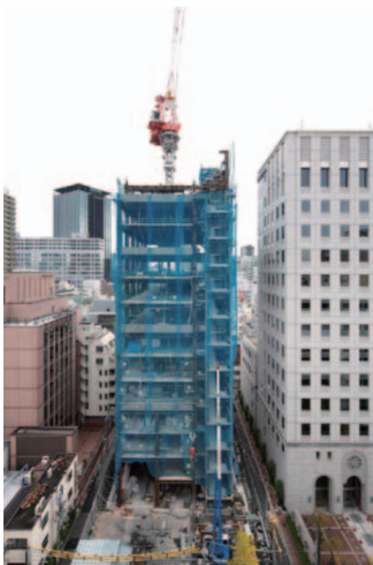
建設工事現況（平成24年11月24日現在）
