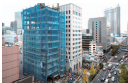
建設工事現況（平成24年11月24日現在）
