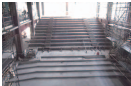
血脇ホール施工状況（平成24年11月21日現在）
