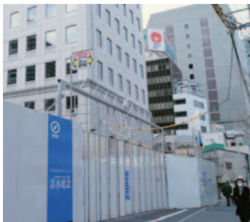
建設現場 (右奥が本館)
