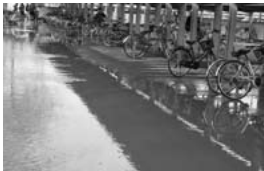
液状化で広範囲に渡って水と泥砂で覆われた千葉校舎大駐車場側駐輪場:平成23年3月11日(金)
