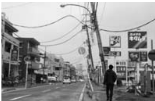
地震により大きく傾いた電柱と液状化で泥砂が大量にあふれた道路:平成23年3月11日（金）、千葉校舎近くの稲毛海岸通り
