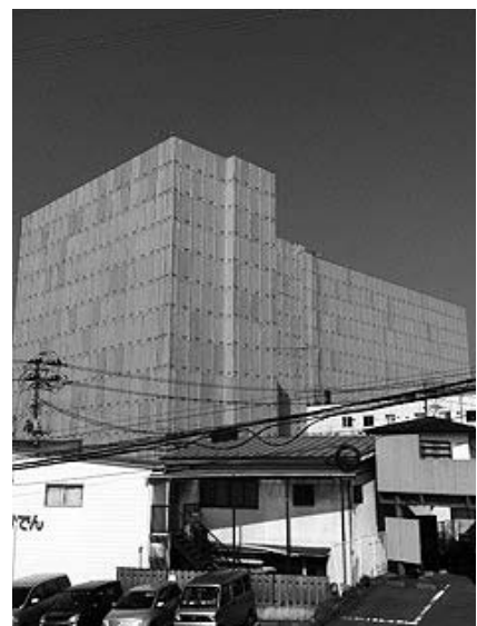
取り壊し中のマンション
