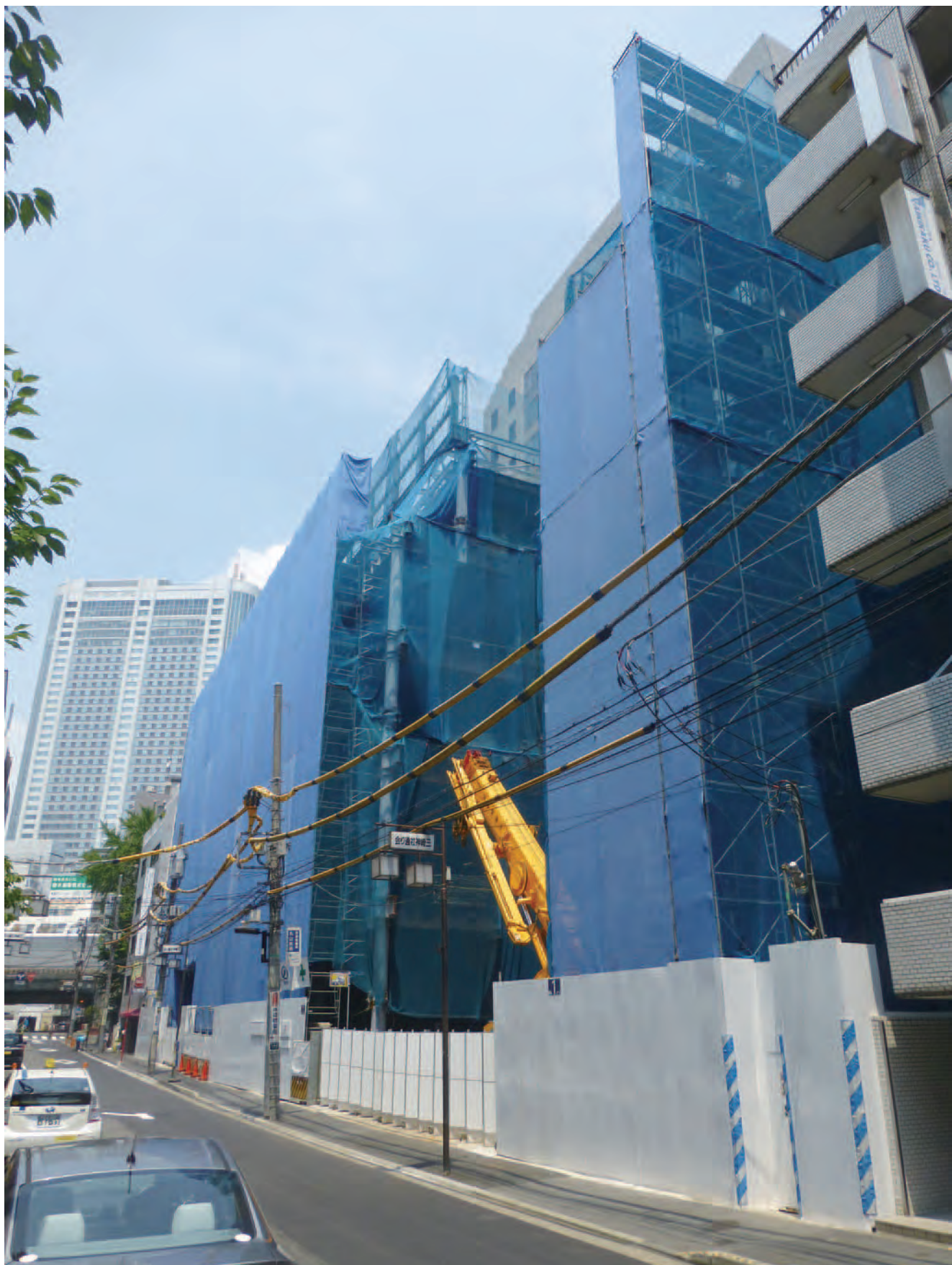
建設が進む本館西棟。画面上方に僅かに覗いて見えるのが本館。
